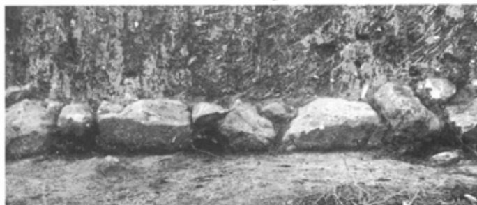
8 suite Autres détails (c et d) de la fondation du mur arrière.
